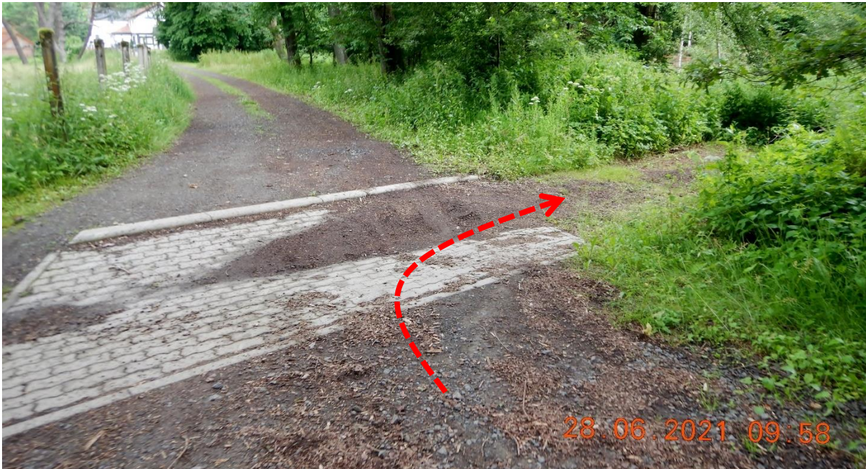
Abb. 56: Querrinne vor der Ortslage
