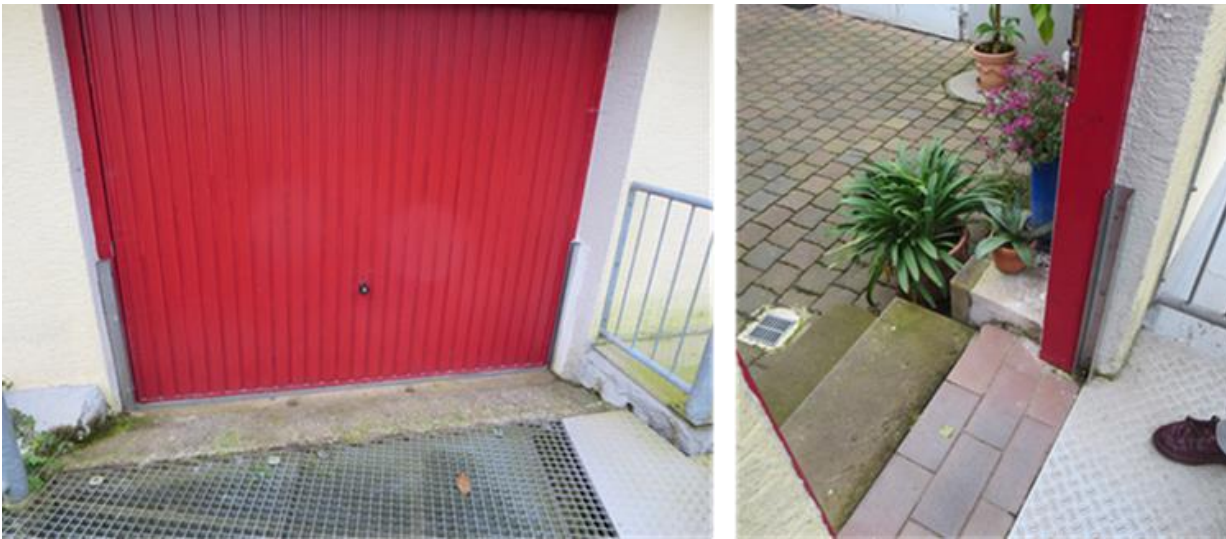
Abb. 20: U-Schienen für Dammbalkenverschlüsse
