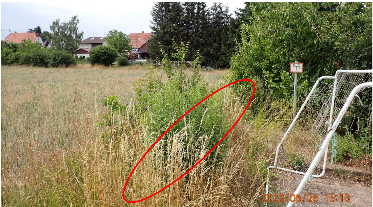
Abb. 28: Zugewachsener Abfangegraben am Übergang vom 1. auf den 2. BA Dellchen
