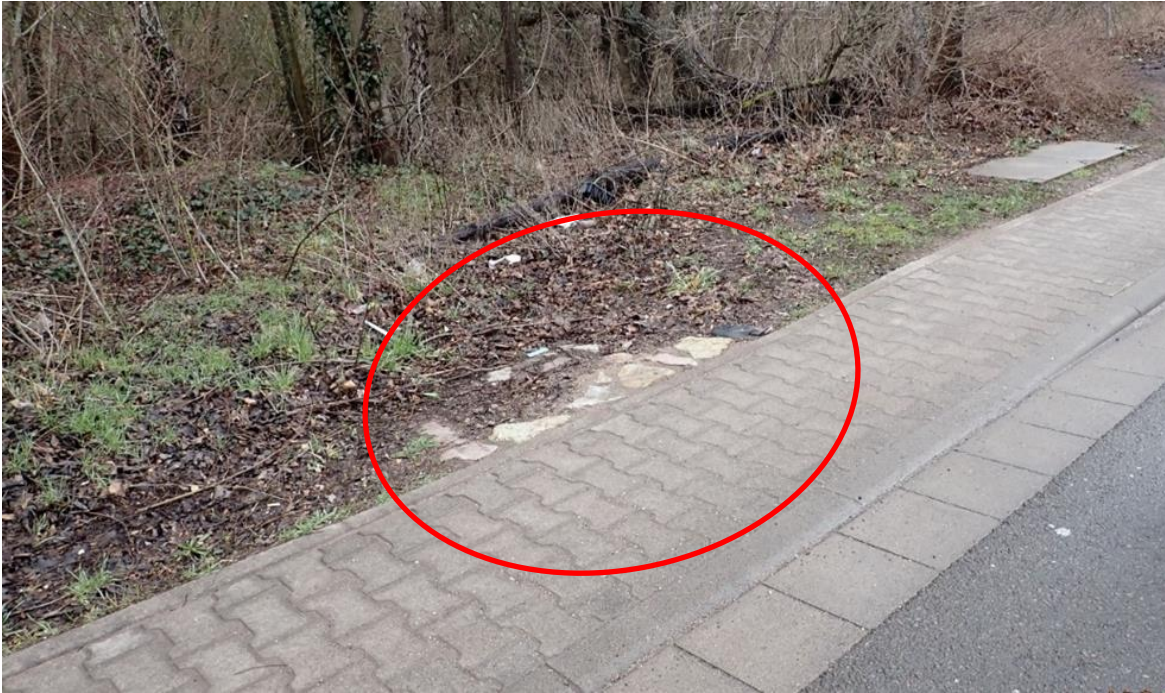
Abb. 51: Regenrückhaltebecken und oberirdischer Zulauf
