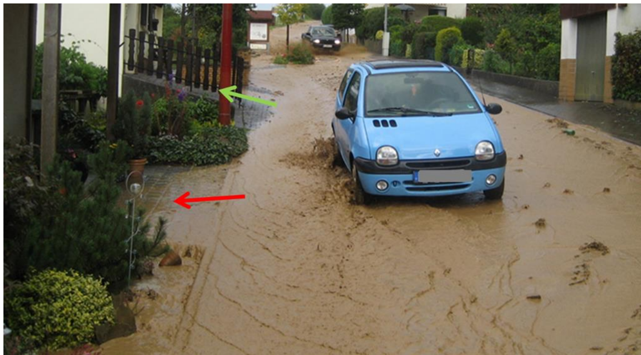
Abb. 16: Überflutungsfördernde (rot) und überflutungsangepasste Bauweise (grün)
