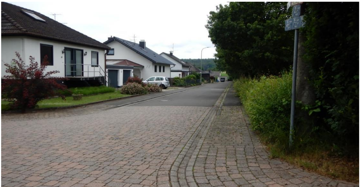
Abb. 75: Überflutungsgefährdete Bebauung in der Baumgartenstraße
