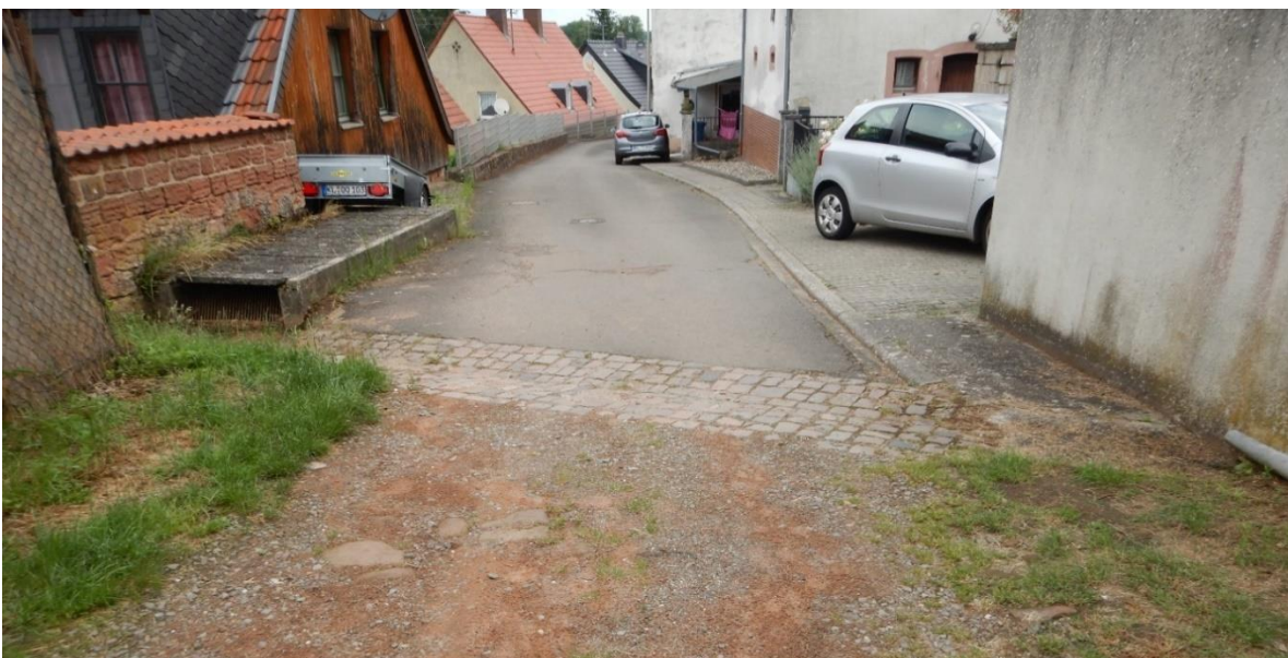
Abb. 63: Querrinne mit Sandfang in der oberen Bornstraße
