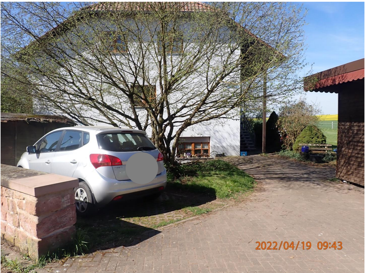
Abb. 84: Überflutungsgefährdete Bebauung auf dem Mehlingerhof
