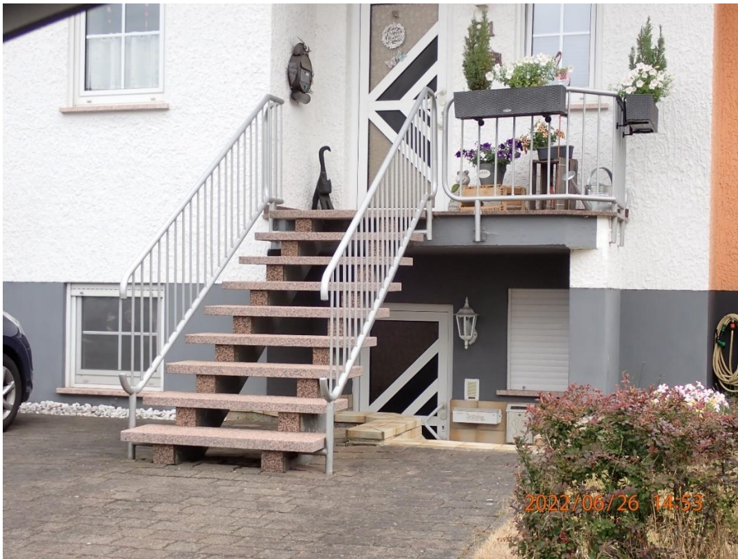
Abb. 12: Überflutungsgefährdete Keller durch außenliegende Tür
