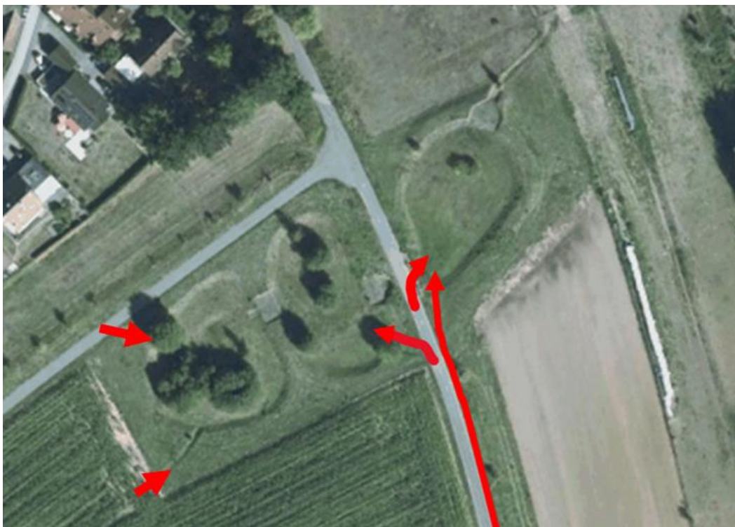
Abb. 35: Zuläufe in die 3-stufige Beckenkaskade
