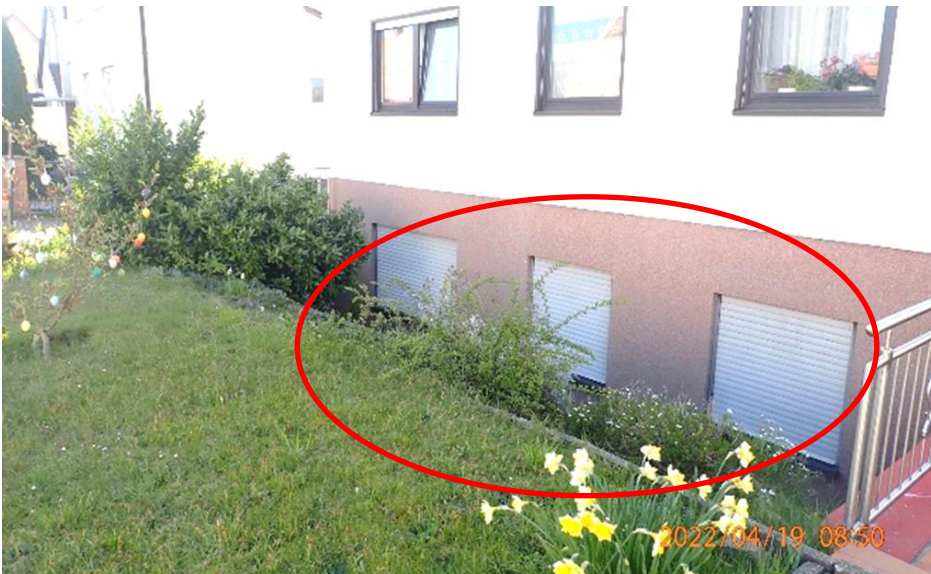
Abb. 13: Beispiele für überflutungsgefährdete Untergeschosse
