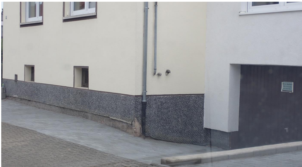
Abb. 24: Beispiele für überflutungsgefährdete Untergeschosse
