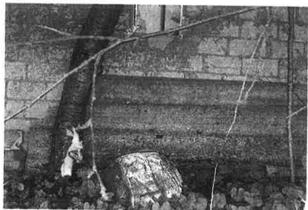
Abbildung 1 Bild von Unrat und Sondermüll (Asbest) im Gebiet ÖG2 (25.08.2021)
